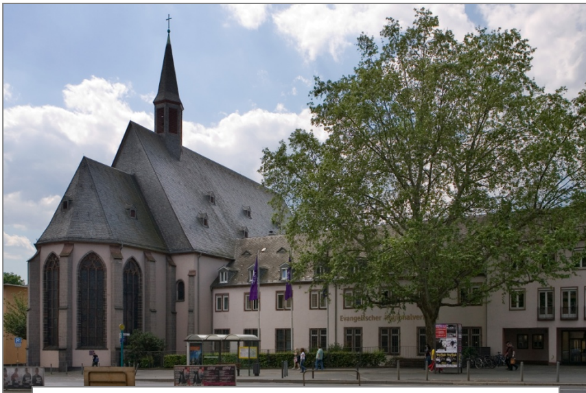
Das (ehemalige) Dominikanerkloster am Frankfurter Börneplatz ist Dienstgebäude des Evangelischen Regionalverbandes („ERV“) und des Stadtdekanats Frankfurt und Offenbach, wie es ab 1. Januar 2019 heißt.
